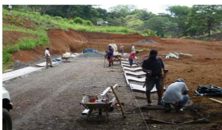
OBRAS EN SERVIDUMBRE N.º 7.
