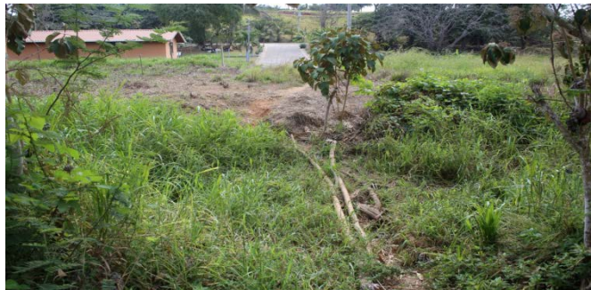
Excavación de zanjas de drenaje 771
