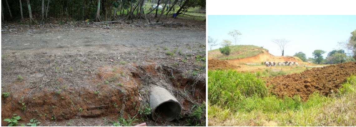
Instalación de tubos de alcantarilla y estructuras de entrada 772
